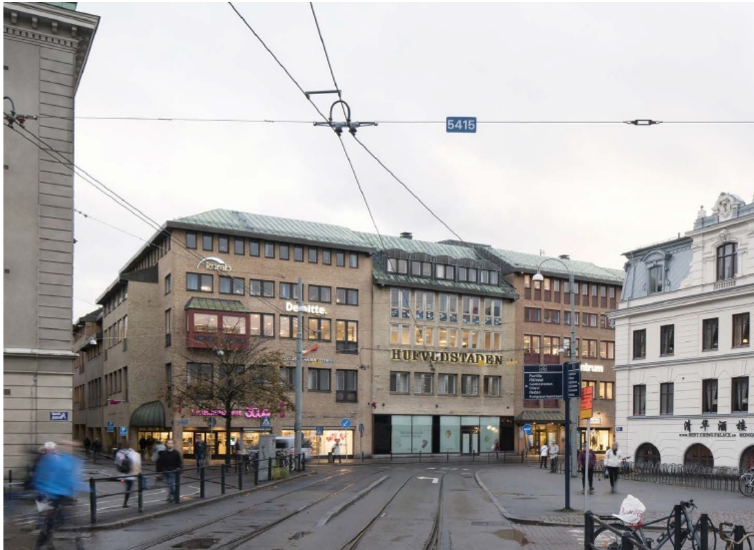
Foto mot Vallgraven 12 (Kv. Härberget), sett från Drottninggatan över Hotellplatsen.
