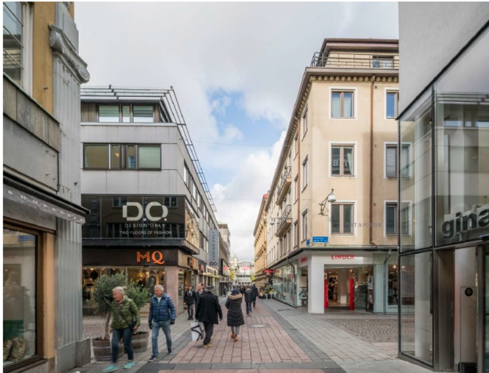
Vy i riktning mot Brunnsparken, sett från Fredsgatan, med befintlig ljus sandfärgad putsad byggnad, som planeras att rivas, till höger.
