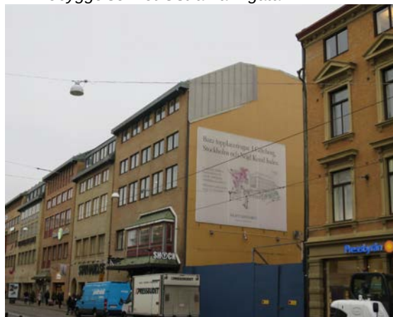
Bebyggelse mot Södra Hamngatan.
